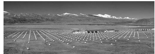
図3 羊八井国際宇宙線観測所全景。白い点状に見えるものがシンチレーション検出器からなる宇宙線空気シャワー観測装置。中心部に制御室や中性子観測装置などの建物がある。
